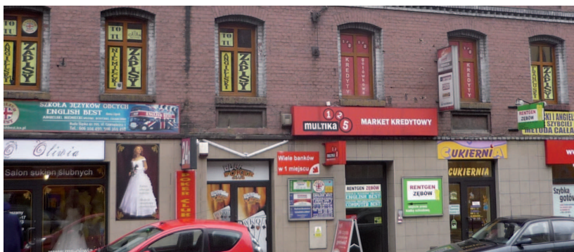
Przykład nieprawidłowego rozmieszczenia reklam na elewacji
